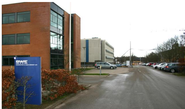
NØ: Kontorbyggeri (Lundtoftegårdsvej 93A, 95-97)
