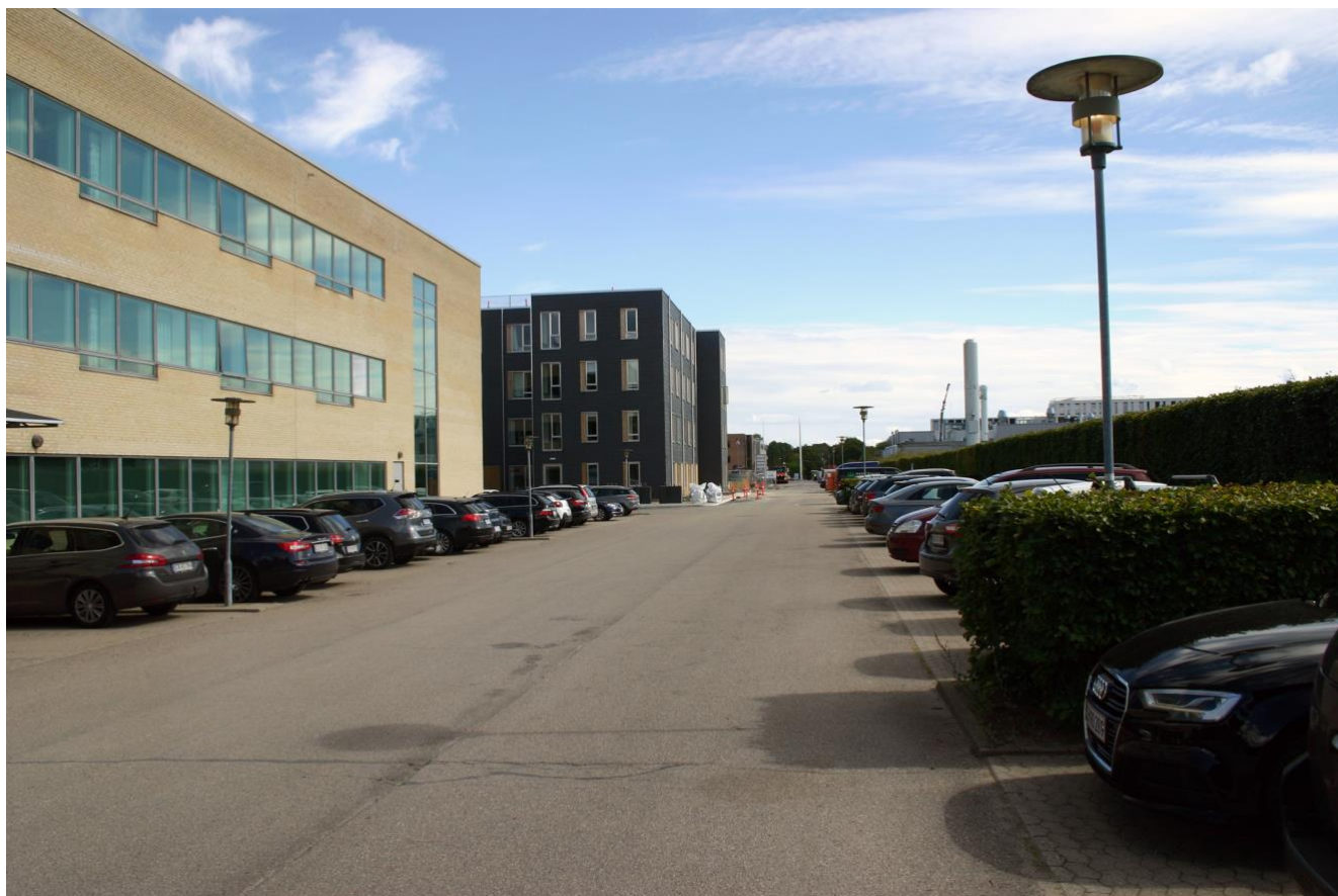
Kvarterets interne vej med Cobham's bygning og ungdomsboligerne tv. og Hempels industrianlæg i baggrunden
