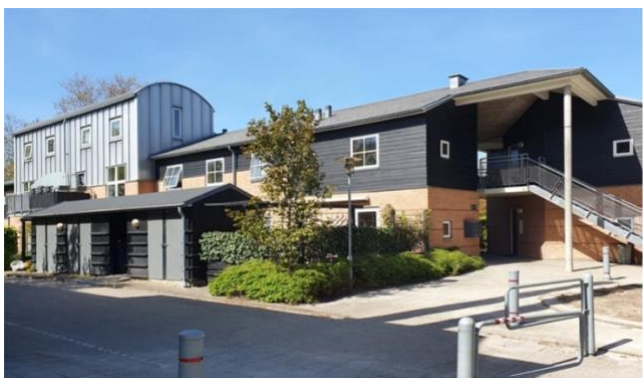
Bygning med tøndehvælvsformet aluminiumstag
