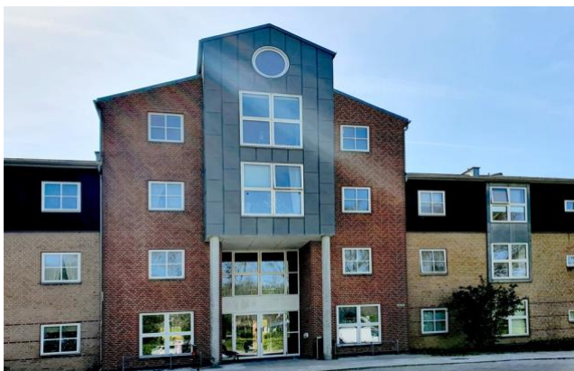
Den højeste bygning i 4 etager rummer ældreboliger
