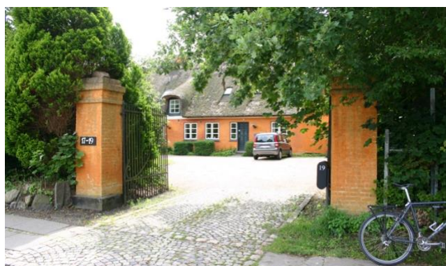
Kig ind til gårdspladsen og en stråttækt længe
