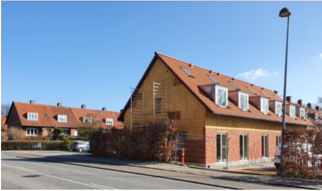
På Bygtoften er der i 2022 opført 3 rækkehuse i stil med rækkehuse i Bredeparken - efter nedrivning af et parcelhus
