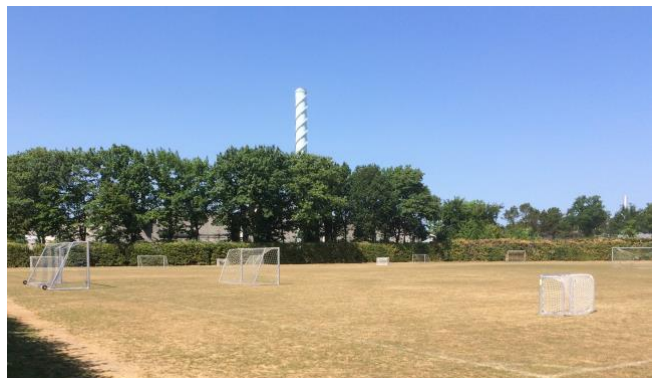
Haldor Topsøes skorsten på Maglebjergvej 22
