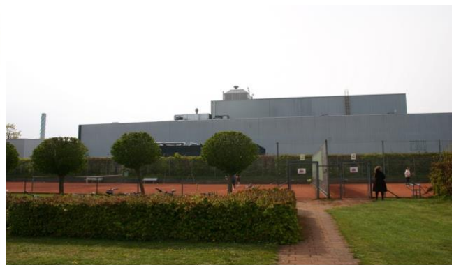
Aquaporin's fabriksanlæg set fra Ravnholmvej
