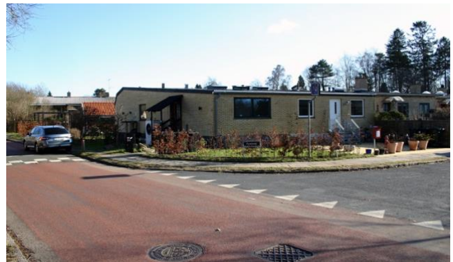
Renoveret enderækkehus på Fynsvej
